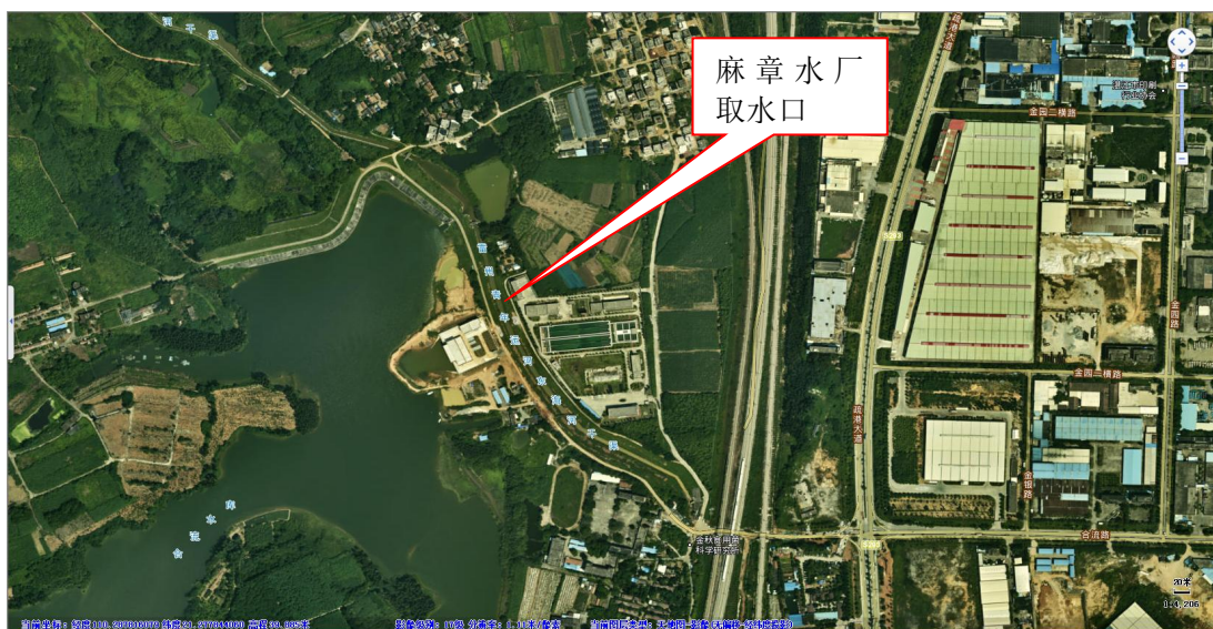
图 5-4 麻章水厂取水口
